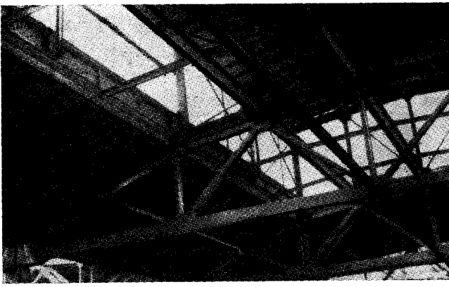
Рис. 6. Общий вид покрытия
