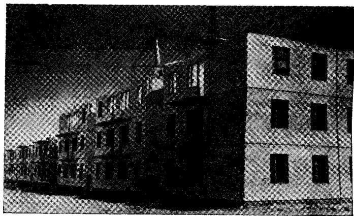
Рис. 3. Монтаж дома улучшенной планировки серии I-K3-464ДС из двухслойных керамзитобетонных наружных стеновых панелей
